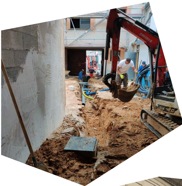
Leuville-sur-Orge travaux de Voiries et Réseaux Divers (VRD)
