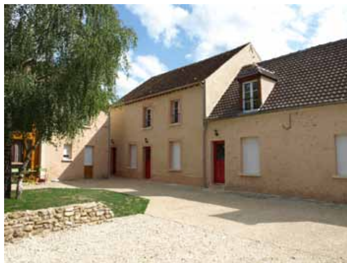
Logements adaptés SNL des Granges-le-Roi.
