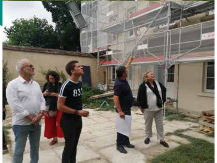
François Petetin montre à Dominique Bougraud, maire de Lardy, la progression du chantier
