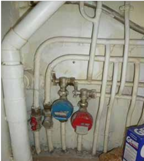
Appt 2e étage gauche Compteurs et robinets sous l'évier
