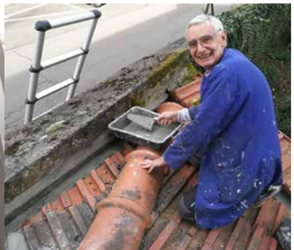
Arnaud répare le toit de l'appentis aux vélos
