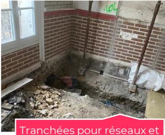
Tranchées pour réseaux et décaissement pour isolation du sol
