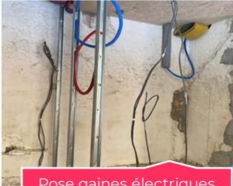
Pose gaines électriques avant cloisons et doublages
